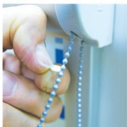
9. Приспустить ткань до нижней границы и установить ограничитель хода. Несколько раз опустить и поднять ткань, проверив работу механизма.
