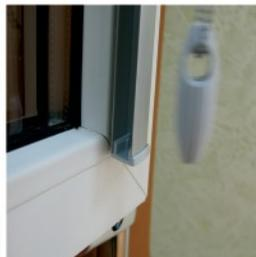
3. Отметить карандашом верхнюю часть направляющей. Снять боковые крышки спирта.
